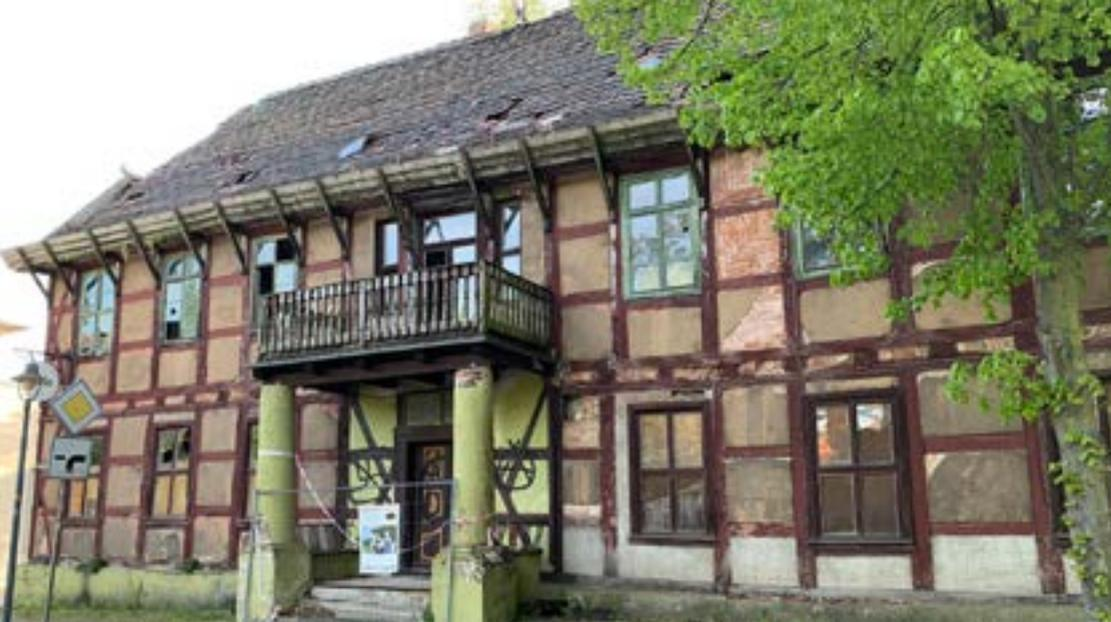
*Sichtbare Schäden an Dach und Fenstern – so konnte Feuchtigkeit leicht eindringen und vielfältige Schäden verursachen*
