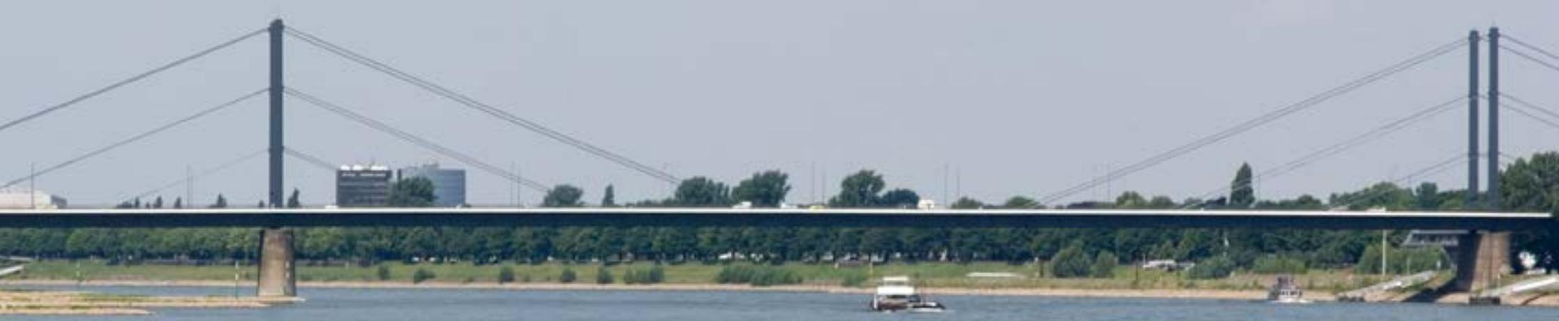
Die Theodor-Heuss-Brücke beeindruckt mit einer Gesamtlänge von 1200 Metern und einer Spannweite von bis zu 260 Metern zwischen den Stützen
