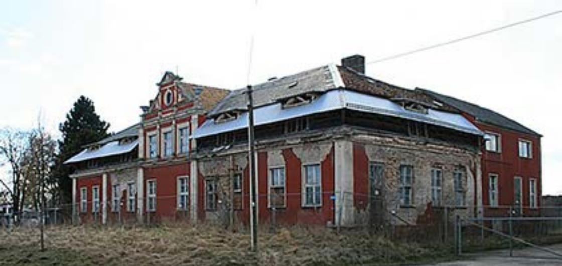
*Das stark geschädigte Gutshaus – behelfsmäßig geschützt von einem Notdach*
