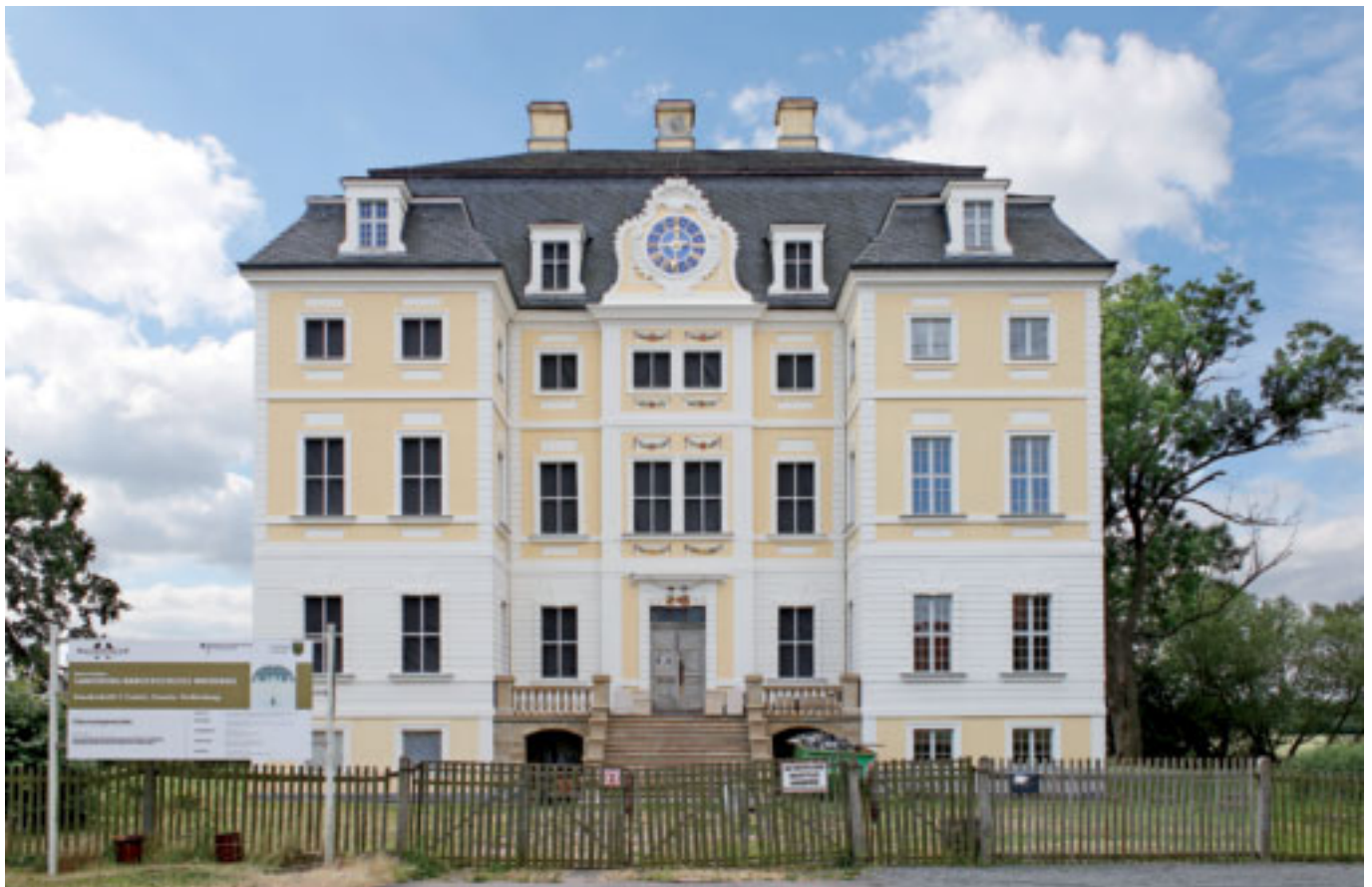
Gesamtansicht von Nord
