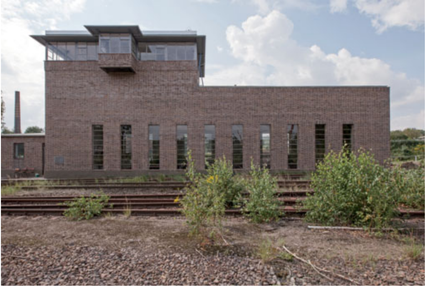
Maschinenhaus der Seilablaufanlage mit aufgesetztem Stellwerk 2
