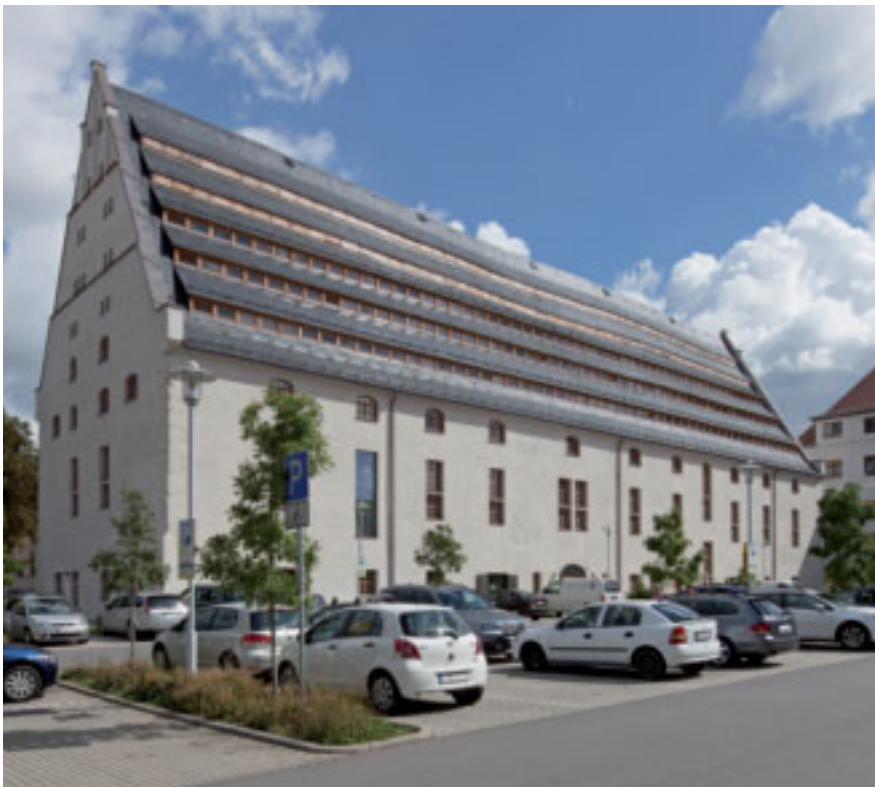
Gesamtansicht von Südwest
