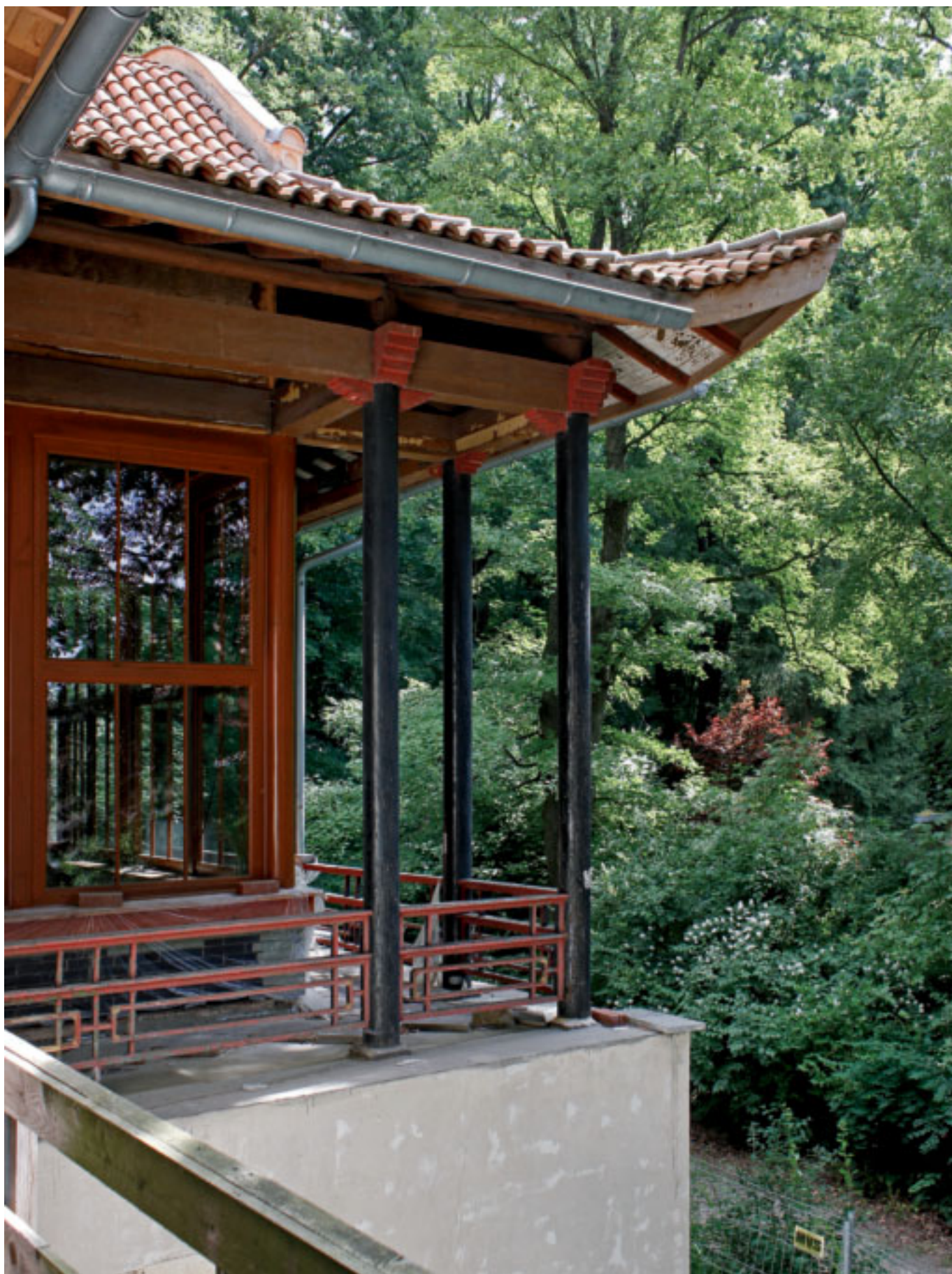
Detail während der Instandsetzungsarbeiten
