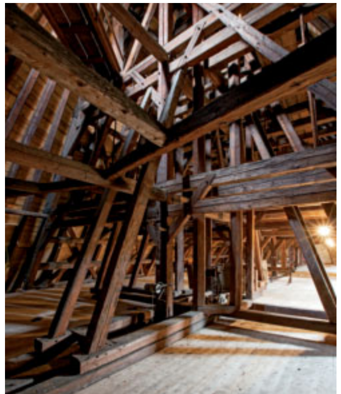
Holzkonstruktion des Dachtragwerkes
