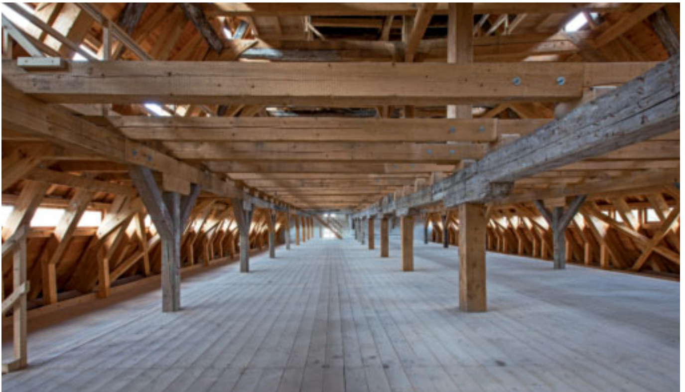
Blick in den Dachstuhl
