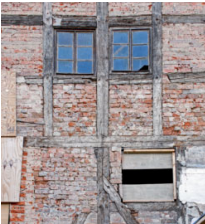
Detail der Hoffassade
