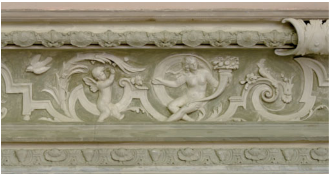
Detail einer Stuckkehle
