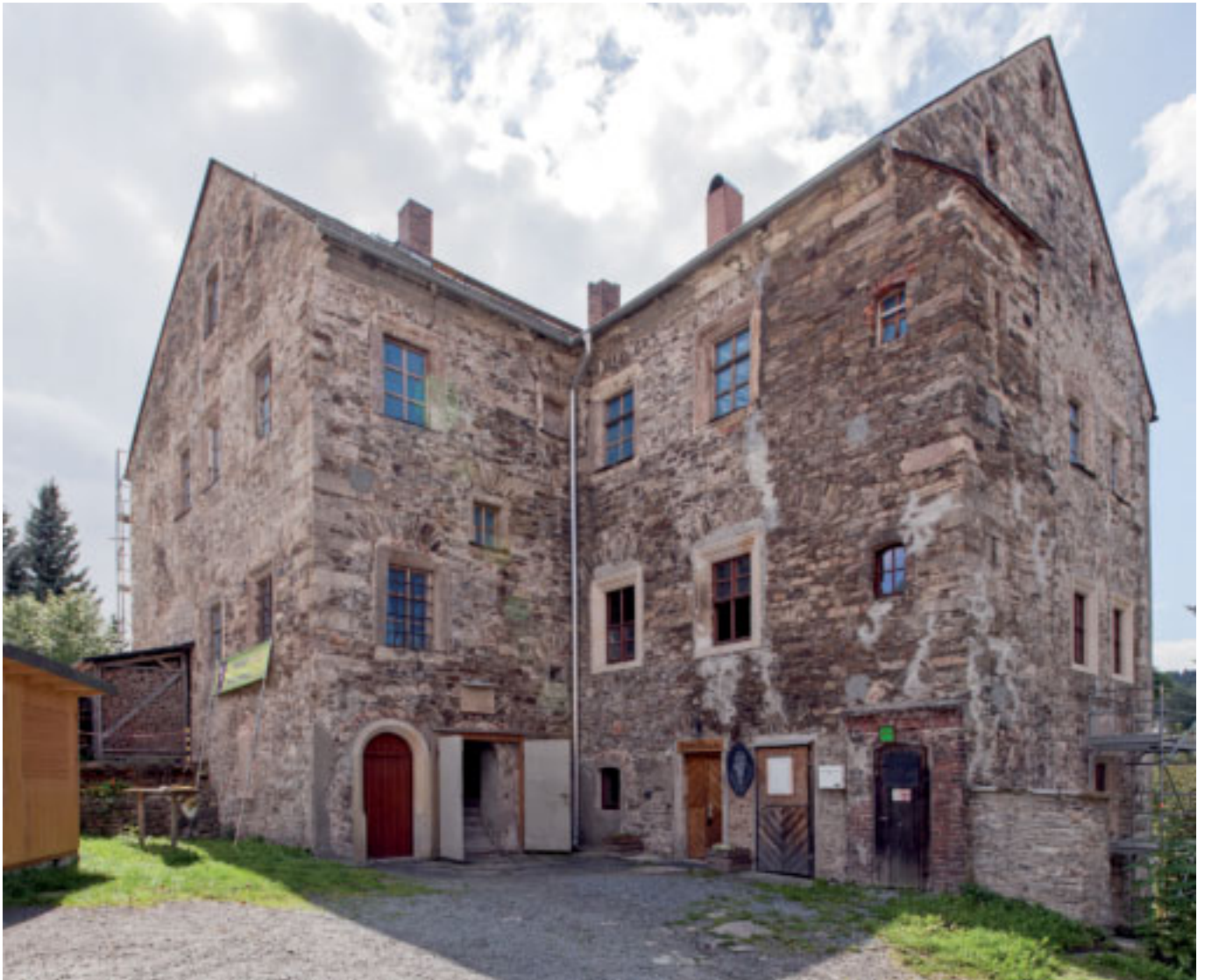
Außenansicht mit Eingangsportal
