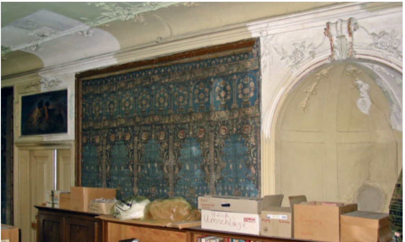
Wandpartie mit Ofennische vor der Restaurierung
