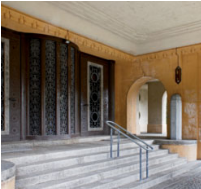
Portalsituation in der Turmfront
