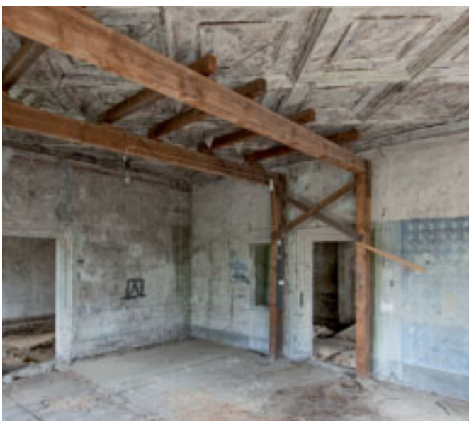
Kassettendecke im ersten Obergeschoss
