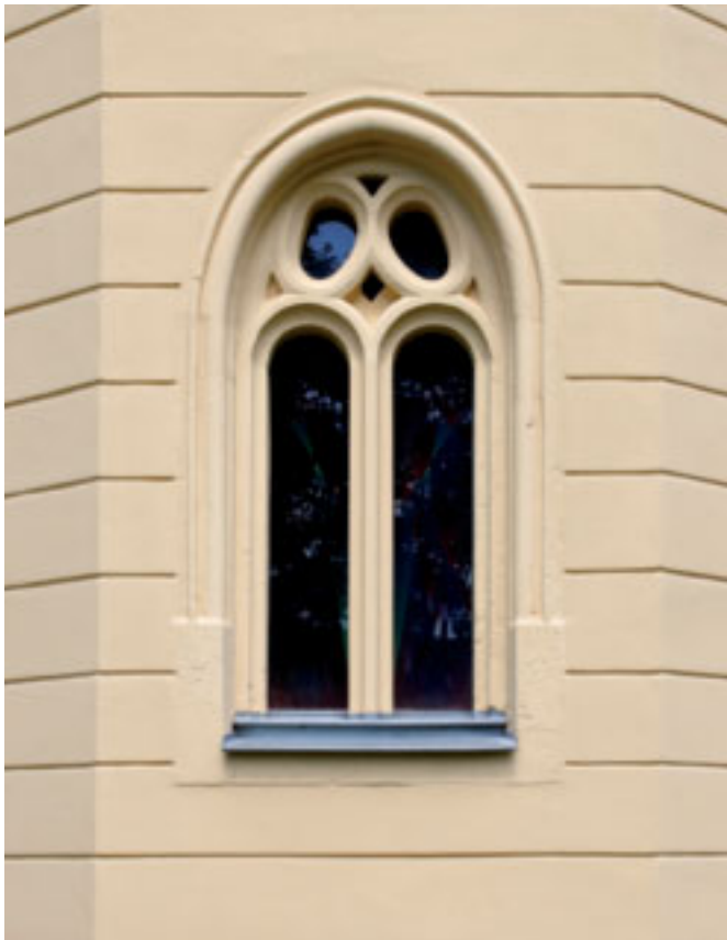
Fenster mit neoromanischem Maßwerk
