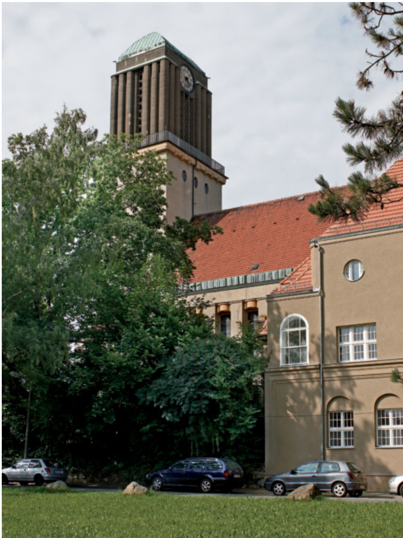
Seitenansicht mit Gemeindehaus
