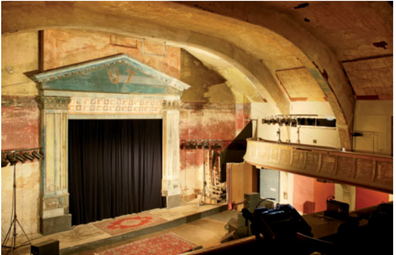
Blick auf die stuckierte Rahmung der Projektionswand
