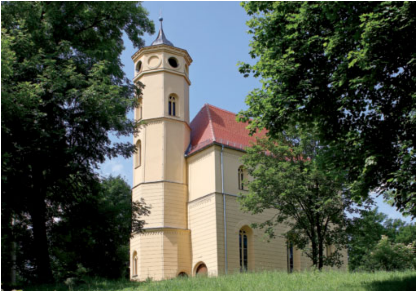
Außenansicht der Kapelle im Gutsark
