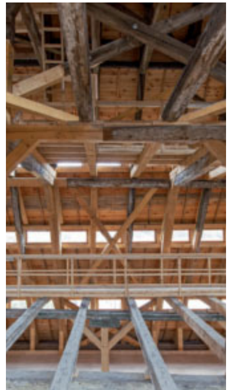
Dachtragwerk nach Ertüchtigung
