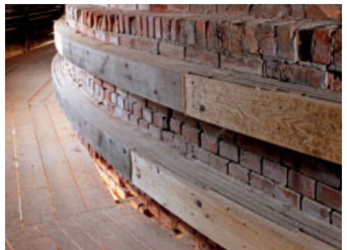
Instand gesetzte Reifenumfassung der Brennkammer
