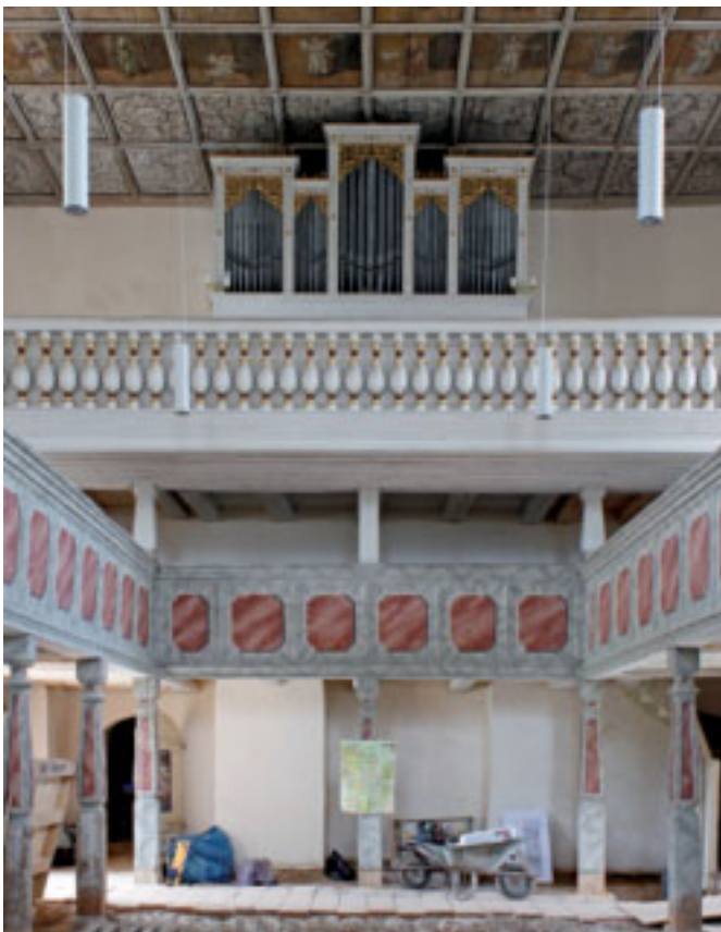
Blick zur Orgelempore während der Baumaßnahmen
